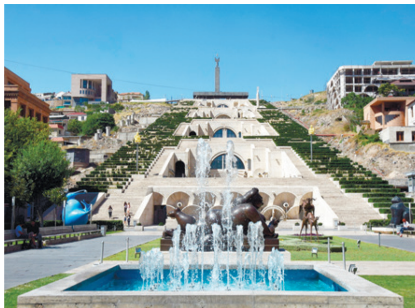
Архитектурно-монументальный комплекс в Ереване. Представляет собой каскад из пяти открытых террас. Связывает центральный район Кентрон с районом Канакер-Зейтун
