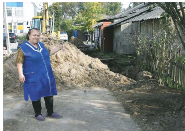
Реконструкция сетей водоснабжения и канализации к жилому дому № 31 ||
