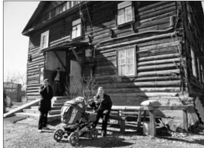
Жильцы аварийного дома
